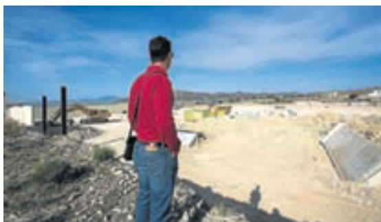
Vista del terreno donde construyen la nueva planta.
