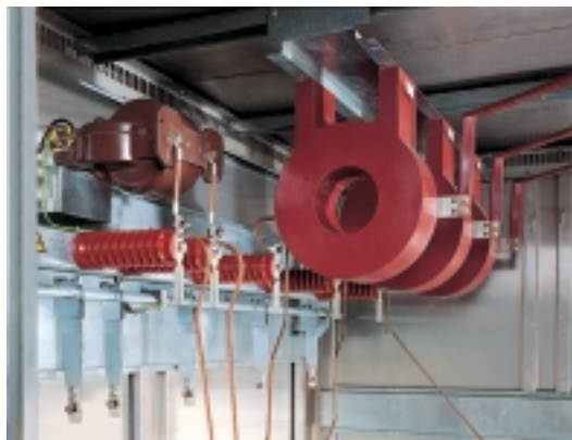
Detalle de las inductancias monofásicas limitadoras de la corriente de conexión.
