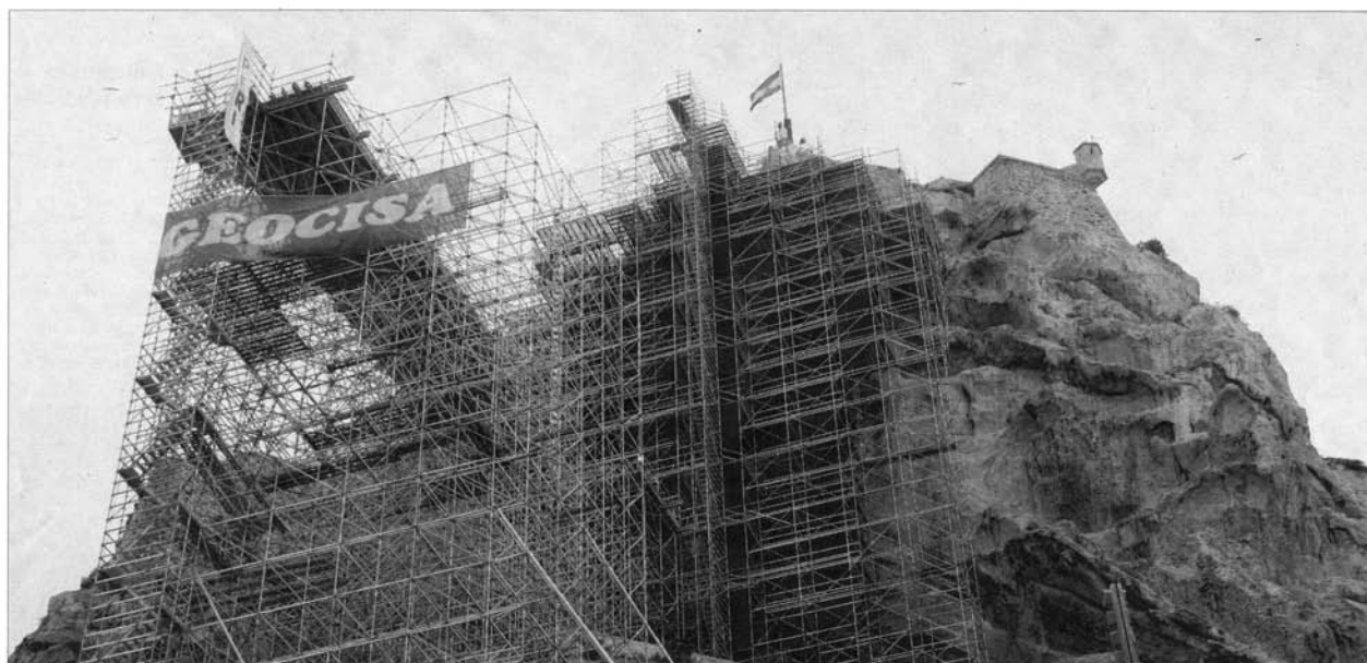
El andamio gigante de Geocisa, de 36 metros de alto y 26 de ancho, cubre por completo la parte del Benacantil conocida como Cara del Moro. /REPORTAJE GRÁFICO DE ALEX DOMÍNGUEZ
