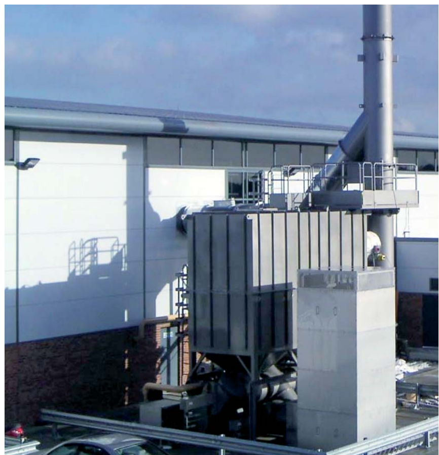
Figura 3. Ejemplo de instalación RTO
