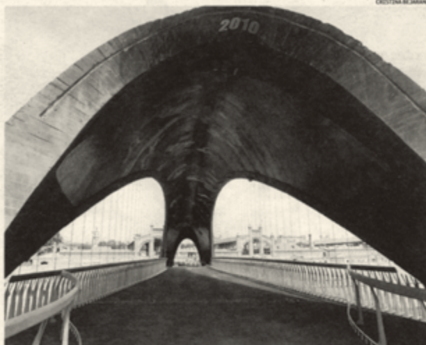
La nueva pasarela peatonal de la zona Río de Madrid, situada frente al Matadero, se la conoce en el barrio como la Capilla Sixtina, debido a los diseños que los vecinos han hecho en su interior. Ha sido realizada en hormigón autocompactante, debido a la complejidad de la estructura
