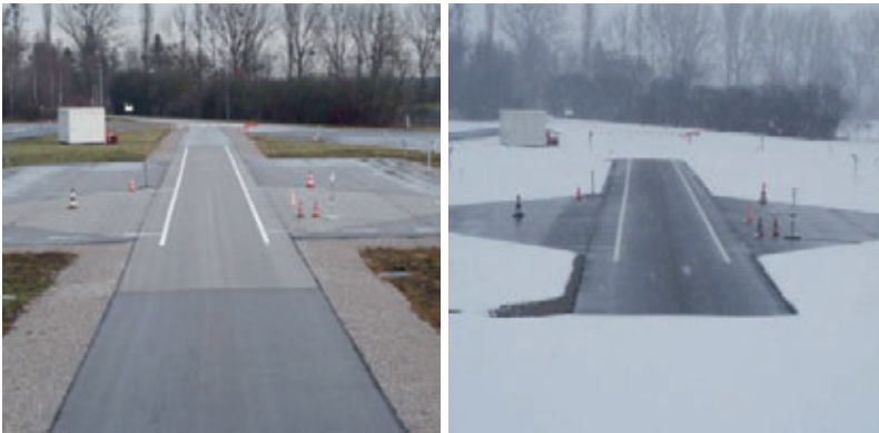
Figura 6: Regulación térmica en pavimentos asfálticos, deshielo de la zona central de la pista (Fuente: www.rehau.com )
